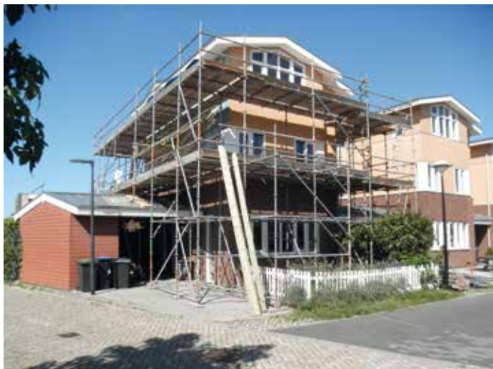
Situatie tijdens de renovatie.
