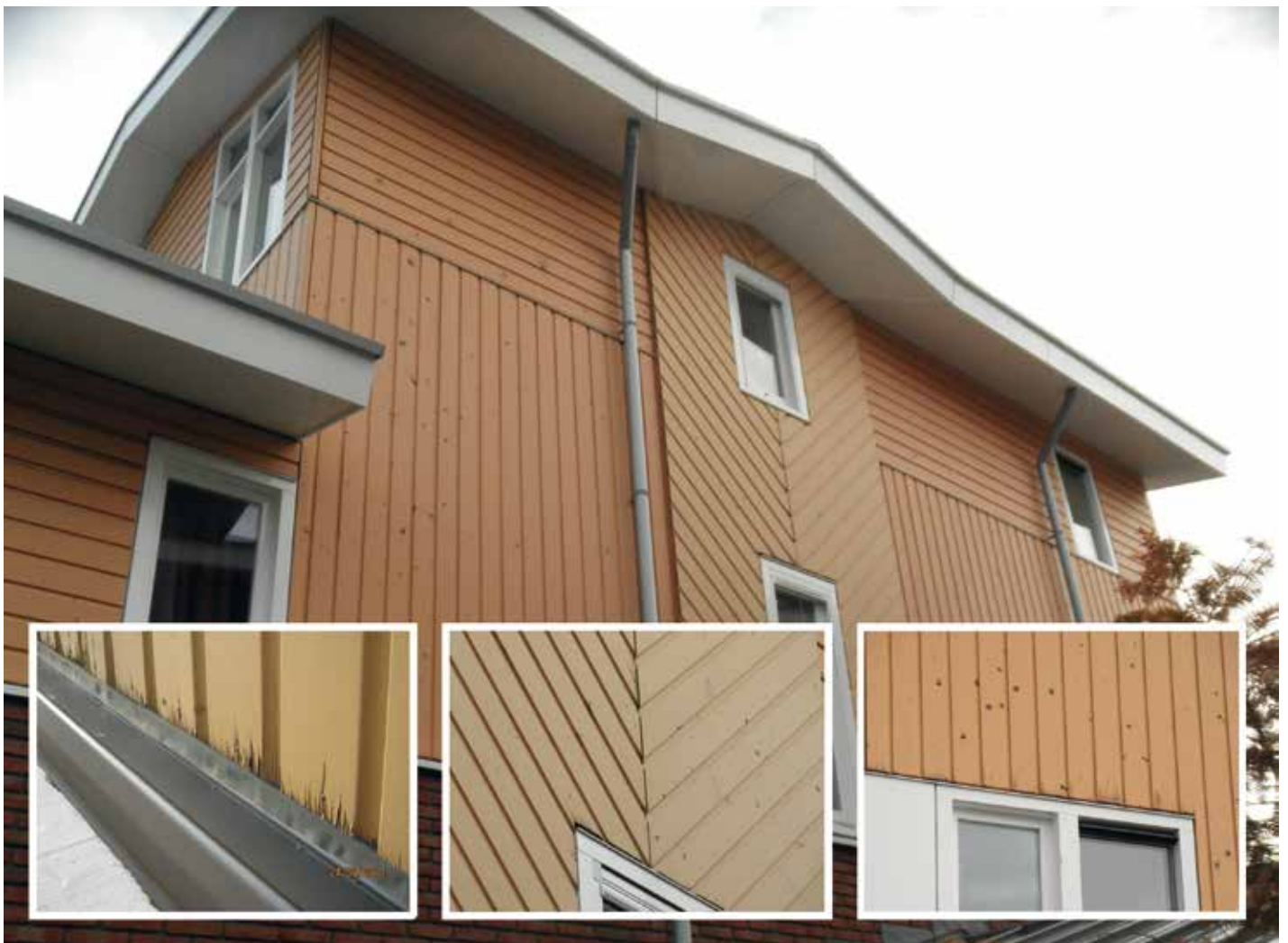
Situatie vóór de renovatie.
